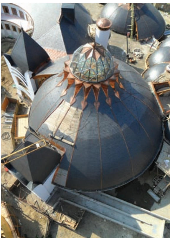
Az épülő makói fürdő
