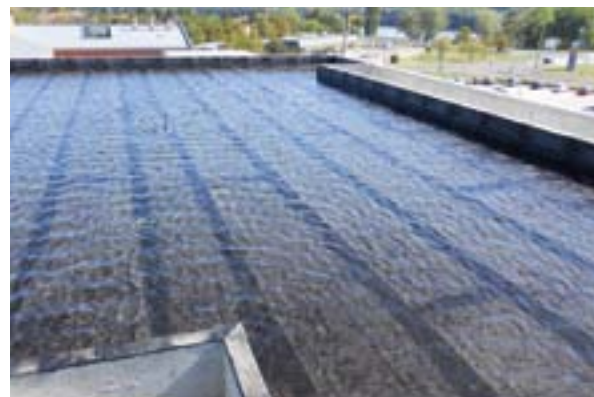
Az elkészült vízszigetelés árasztásos minőségellenőrzése.
