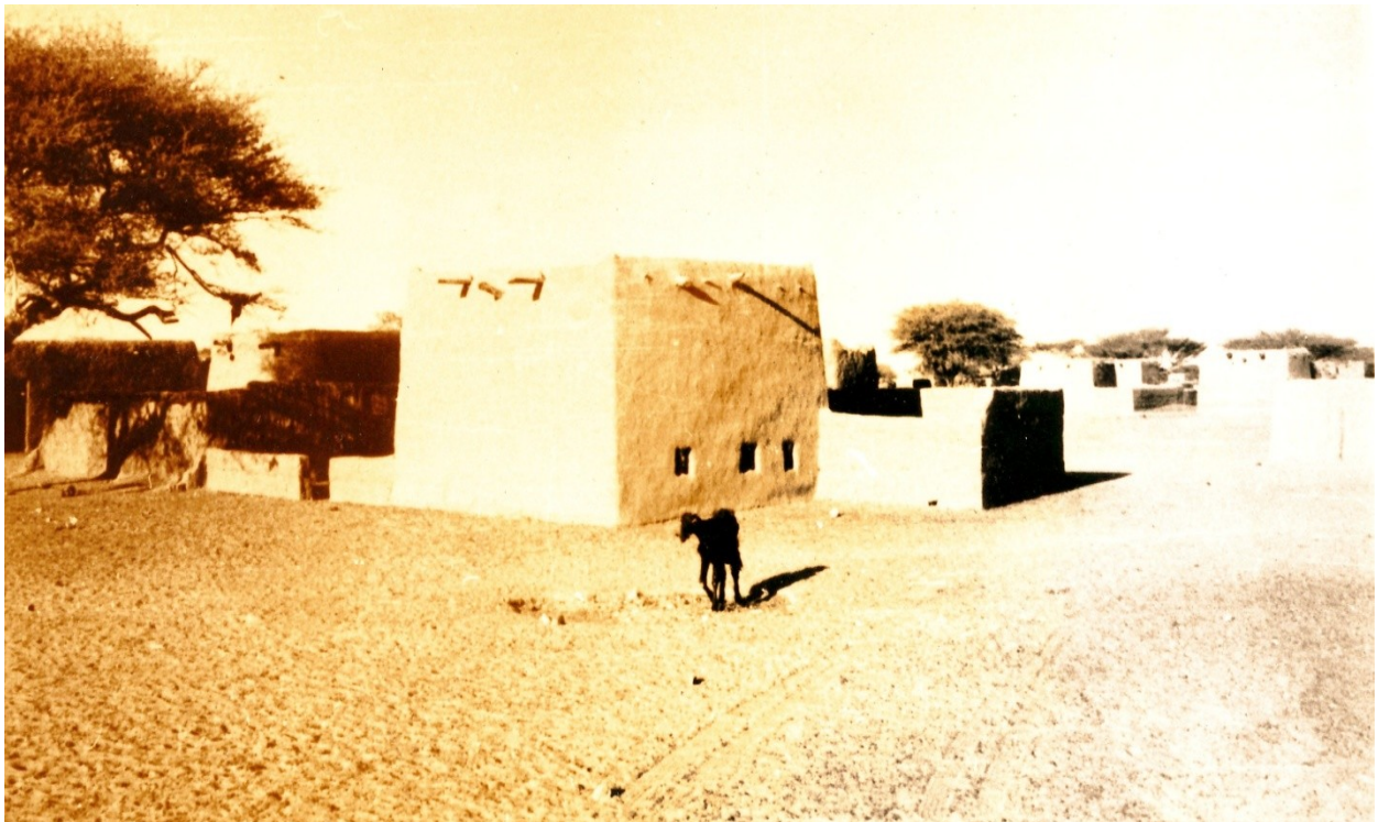
17.sz.ábra TIPIKUS LAKÓHÁZ A SZAHARÁBAN. (Szerző felvétele) AZ ALACSONYAN ELHELYEZETT NYÍLÁSOK CÉLJA, HOGY A FEKVŐHELYEK MAGASSÁGÁBAN AZ OTT URALKODÓ ÁLLANDÓ SZÉL JOBB HŐÉRZETET TEREMTSSEN
