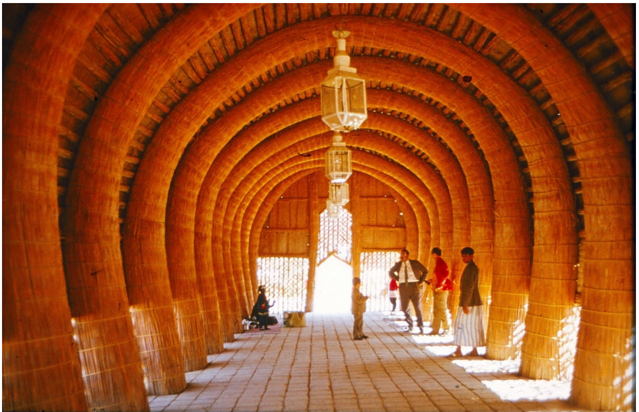
BASRAI MOCSÁRVILÁG TÖRZSI SÁTRA ALUL ÁTTÖRT FONATTAL A SZÉLJÁRÁS ELŐSEGÍTÉSÉRE ÜLŐ MAGASSÁGBAN, HOGY ELŐSEGÍTSE A HŐLEADÁST BAGDAD SZABADTÉRI MÚZEUM SZERZŐ FELVÉTELEI
