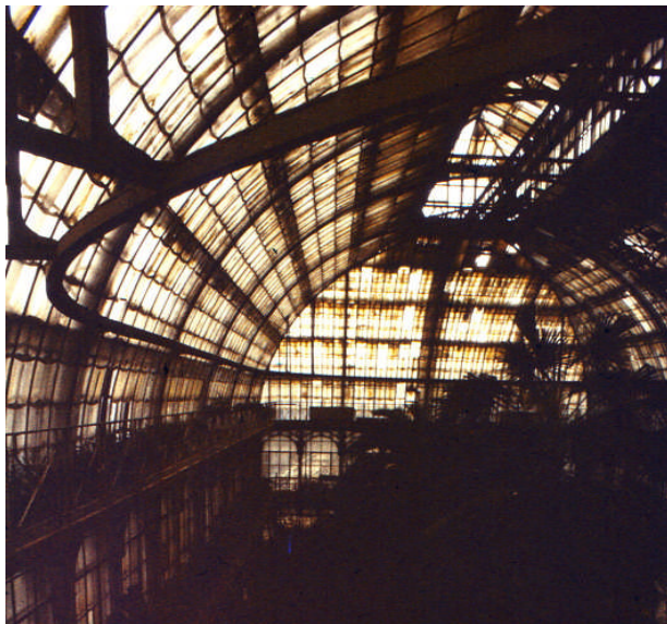
10. sz. ábra ELALGÁSODOTT ÜVEGEZÉSŰ PÁLMAHÁZ
