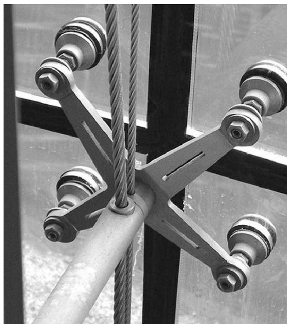
16.sz. ábra HŐSZIGETELŐ ÜVEGEZÉS PONTMEGFOGÁSOS SZERKEZET METSZETE ÉS ÁTVÁNYA
