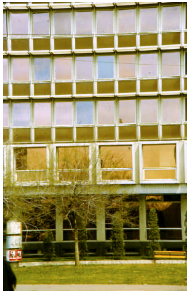
52.sz. ábra A TÖNKREMENT ÜVEGEK CSAK ELTÉRŐ SZÍNŰEKEL CSERÉLHETŐK KI, MERT AZ EGYKORI TECHNOLÓGIÁT MÁR NEM ALKALMAZZÁK
