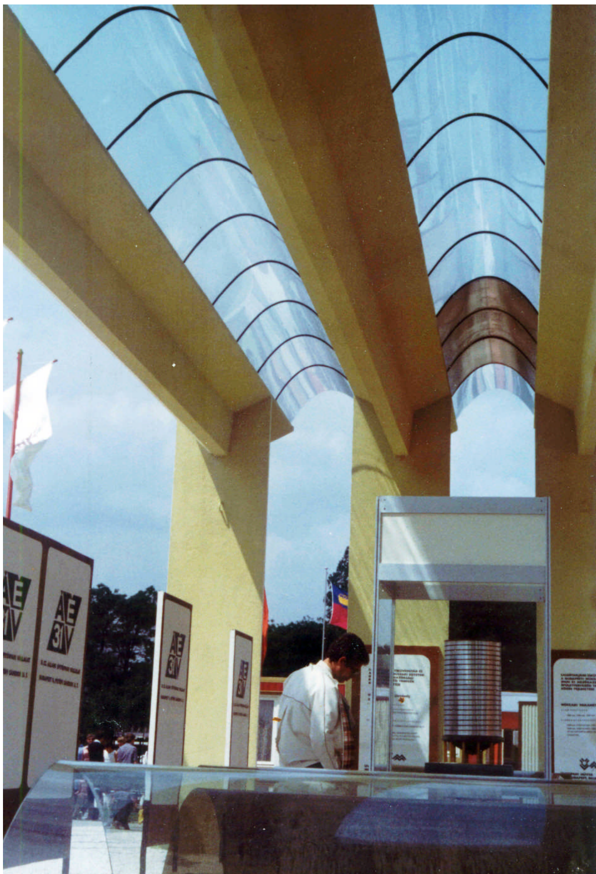
80. sz. ábra SZÁRAZ SZERELÉSŰ HŐHÍDMENTES FELÜLVILÁGÍTÓ ÖNHORDÓ PARABOLA SZELVÉNYŰ RAGASZTOTT ÜVEGGEL
