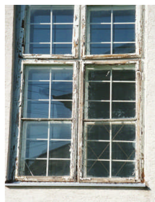
68. sz. ábra A GERÉBTOKOS KETŐS ÜVEGEZÉSŰ RÁCCSAL VÉDETT ÉPÜLET FELÚJÍTÁS ELŐTT
