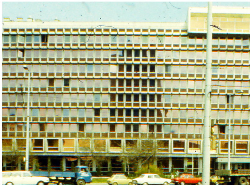
52.sz. ábra A TÖNKREMENT ÜVEGEK CSAK ELTÉRŐ SZÍNŰEKEL CSERÉLHETŐK KI, MERT AZ EGYKORI TECHNOLÓGIÁT MÁR NEM ALKALMAZZÁK
