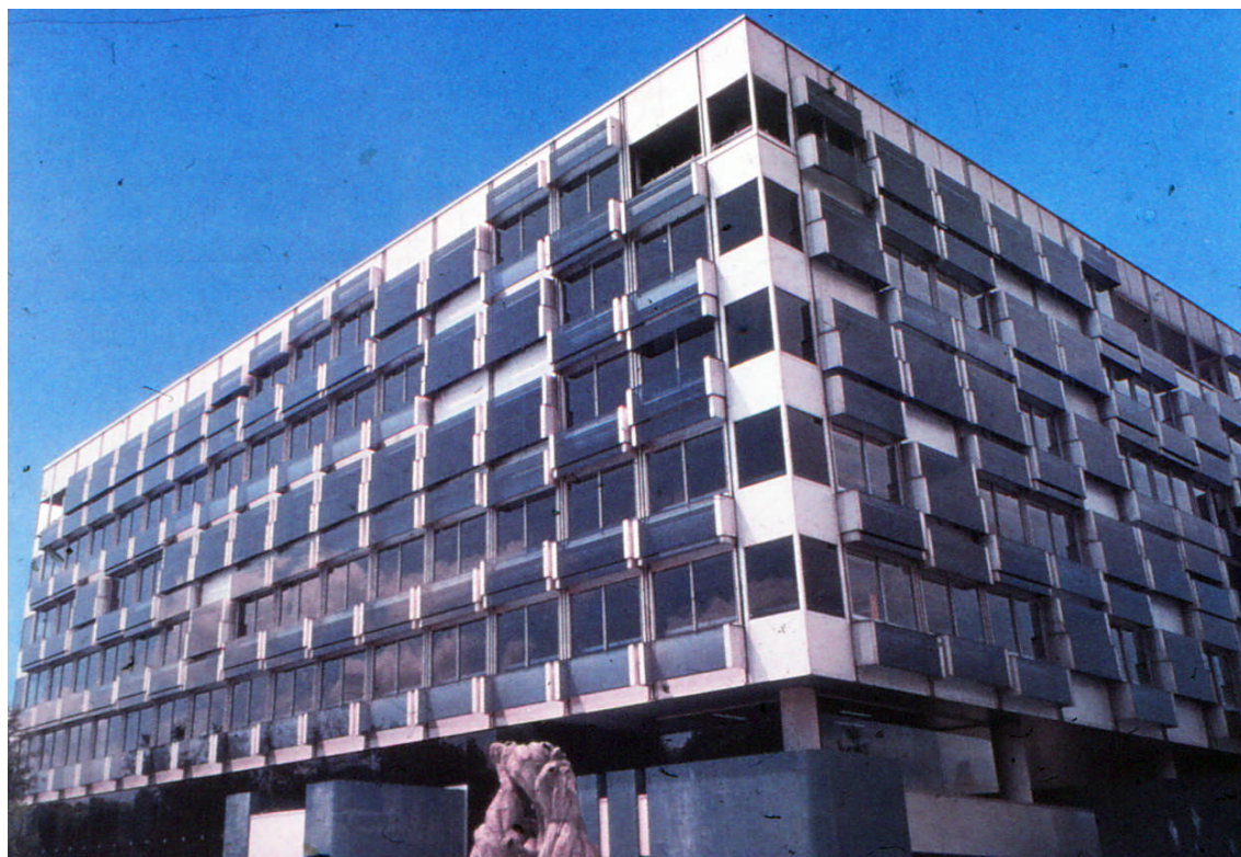
59.sz. ábra GÉPI MOZGATÁSÚ ABSZORPCIÓS ÁRNYÉKOLOÓ ÜVEGEZÉS
