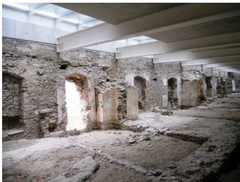
A terasz alól a feltöltésből kiszabadított kora újkori szárny új födémmel
