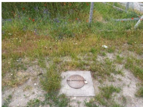
7. kép: Kármentesítési monitoring kút (zárt)
